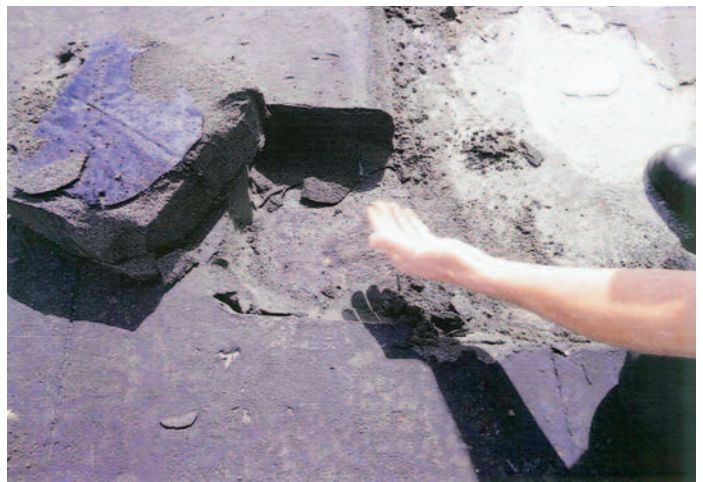
Exempel på brister vid installation av isolering som del i en grön takanläggning.
