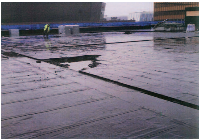
Exempel på brister vid installation av isolering som del i en grön takanläggning.
